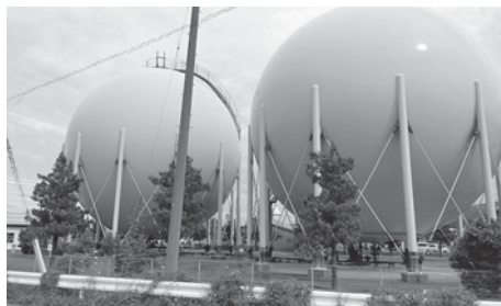
ガス中央供給所(平牛地内)
