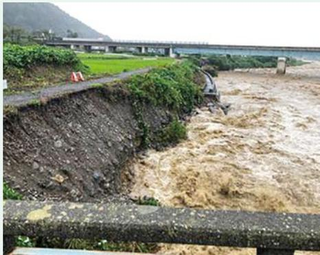
令和元年(2019年)10月台風19号により堤防が欠損した早川(田屋地区)
