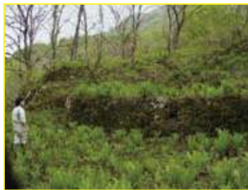
鉱山事務所跡の石垣
