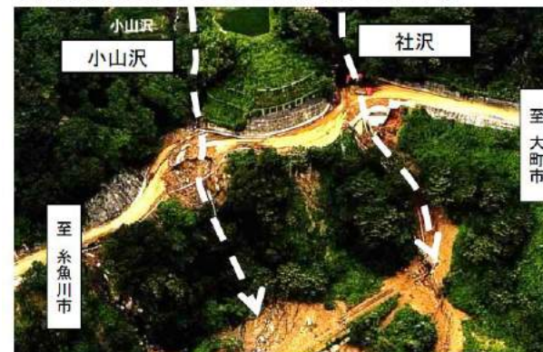
写真:整備前(H7年7月豪雨災害の被災状況)
