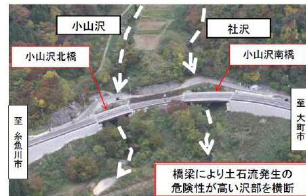
写真:整備後(H23年12月開通区間)
