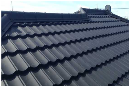
金属瓦（日本瓦調のもの）の例
