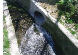
取水口+上水槽(チロリアン取水、兼スクリーン)
