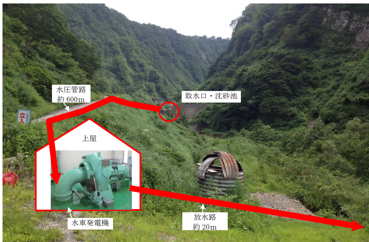
図 4. 2. 4 水圧管路の布設位置
