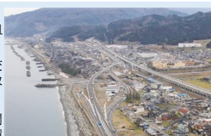
平成27年5月部分開通 糸魚川東バイパス
