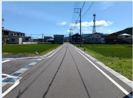
新設された市道大排水路線
