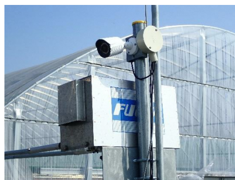
防犯カメラの設置
