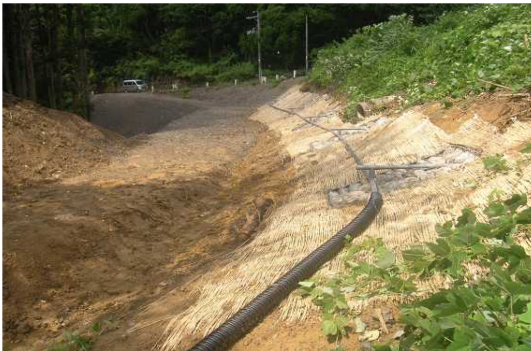
イ 集水ボーリング工事（平成24年度） 総延長342.0m（VP50×7本）
