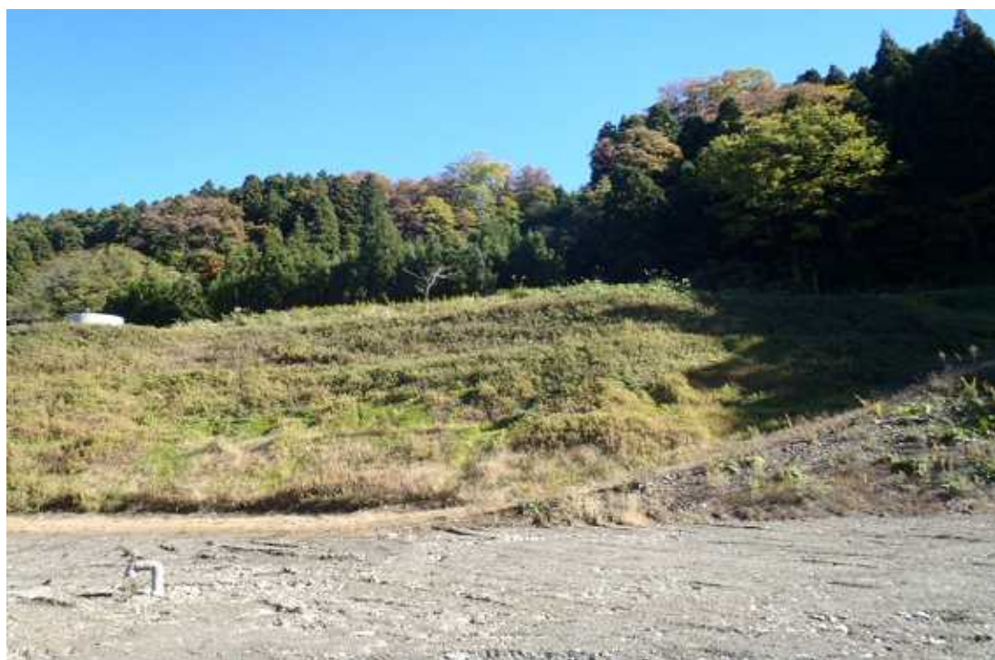
(ウ) 竣工（法面整形後）
