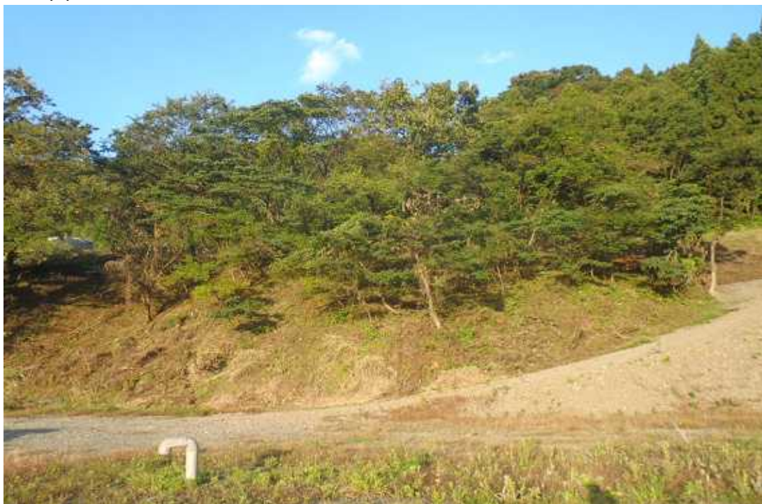
(イ) 着手前（法面整形前）
