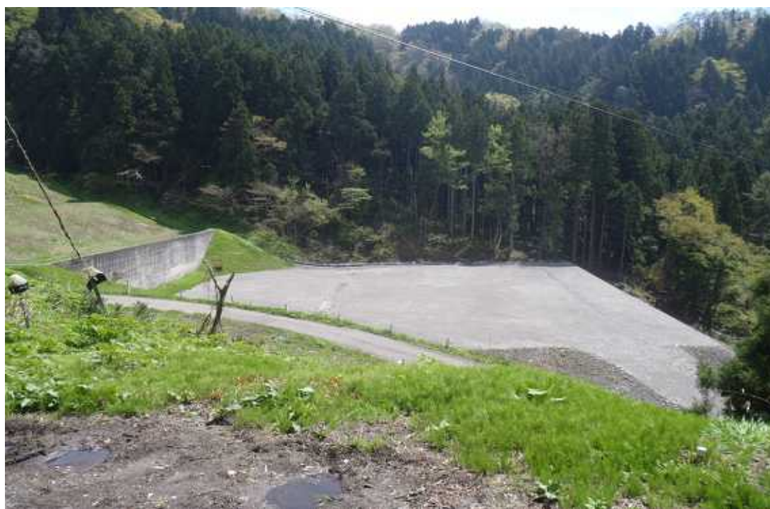
ウ 治山堰堤補強工事（平成24年度～平成26年度） 盛土工9,700m 3
