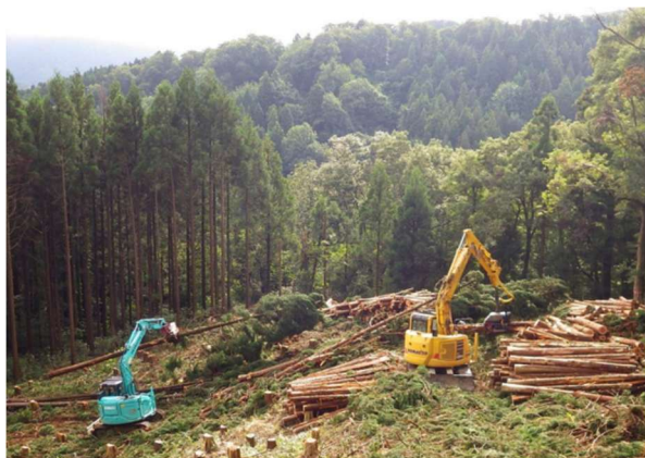
主伐・再造林(上路地内)
