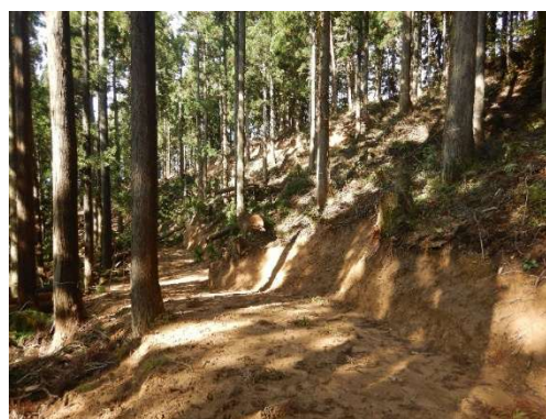
森林作業道(大和川地内)
