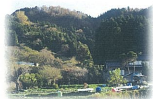
山塊崩落跡の十二社川
