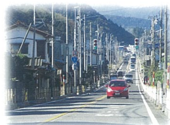
安全対策が急務の国道 8 号線
