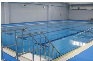
サブプール(16m×4コース 水深0～1.1m 稼働中)
