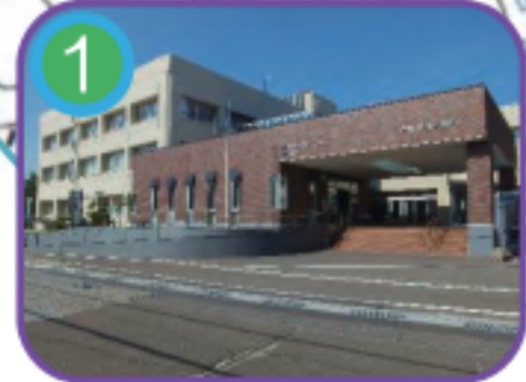
能生生涯学習センター (指定避難所) 3階建・海拔 7.0m
