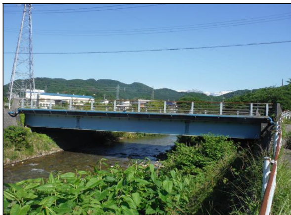
写真全景（鋼橋）
