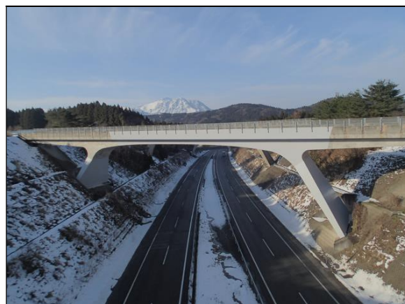
写真全景（コンクリート橋）
