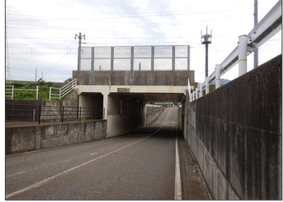
川原線地下道
