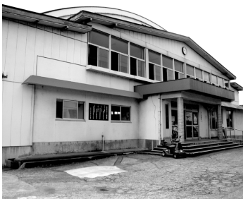
能生事務所横の能生体育館
