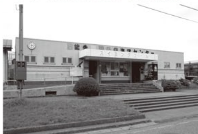
能生B&G海洋センタープール
