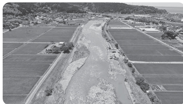
能生川被災箇所
