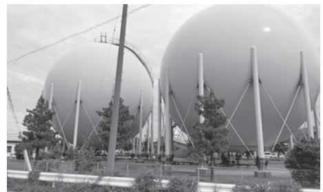
ガス中央供給所(平牛地内)
