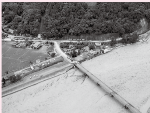
■ 姫川 上刈地先堤防決壊状況
