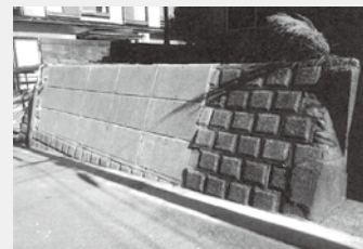
造成ブロックの改良工事
