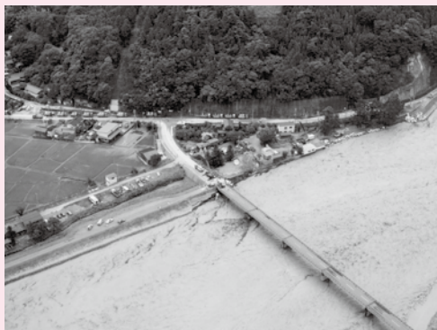
■ 姫川 上刈地先堤防決壊状況
