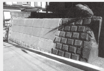
造成ブロックの改良工事
