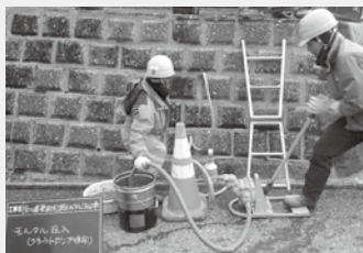
ブロック背面へのポンプ 圧力によるモルタル注入
