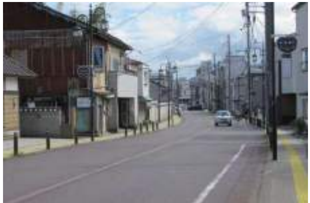
④ 中央通り (市道南本町線)
