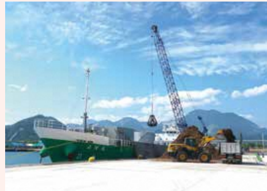
完成した西ふ頭3号岸壁での災害廃棄物の荷揚げ
