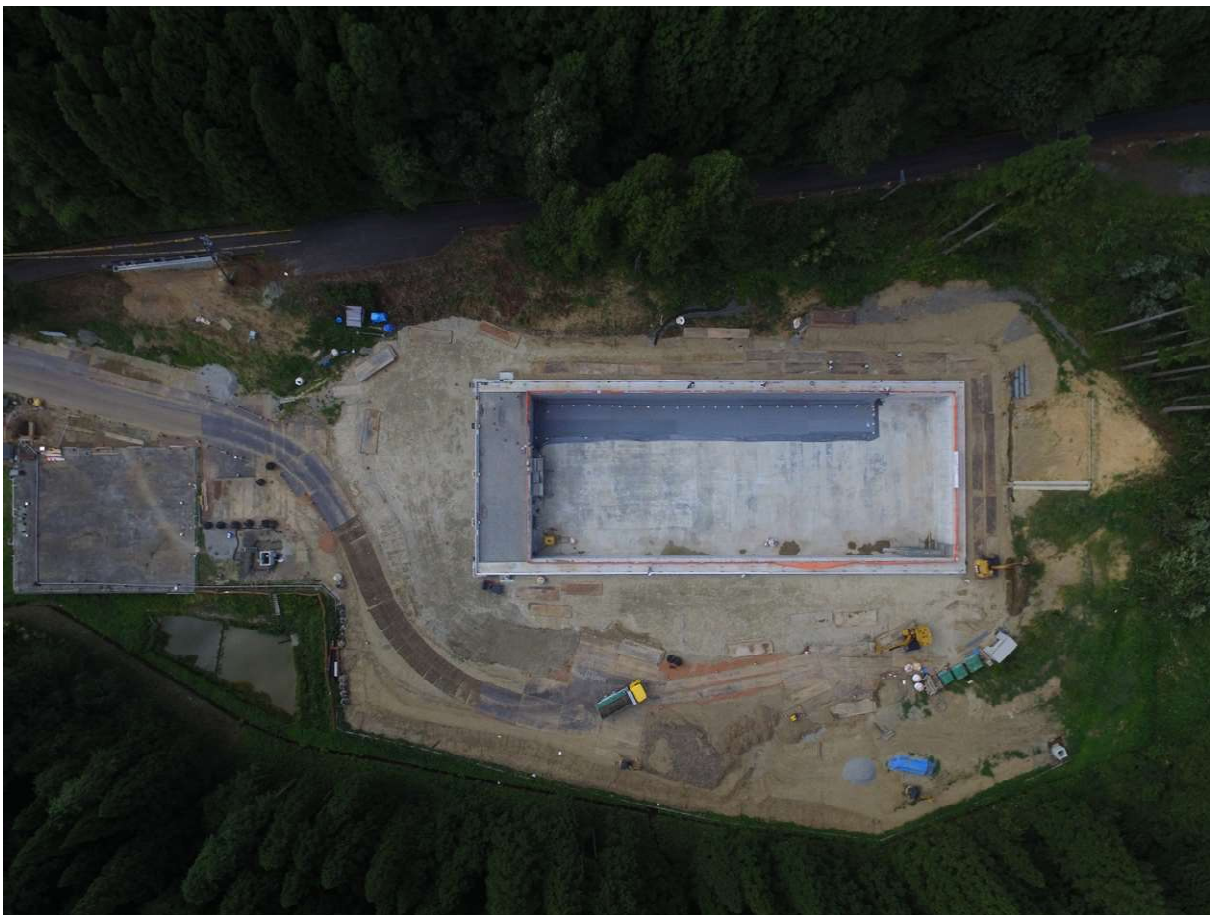
貯留構造物 搬入スロープ遮水シート施工中
