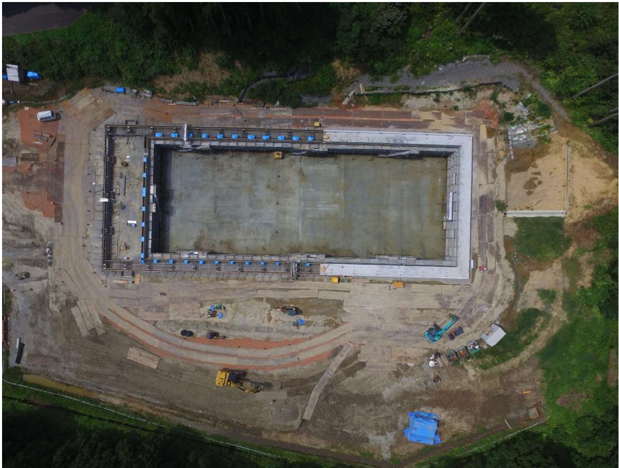
貯留構造物 コンクリート打設中
