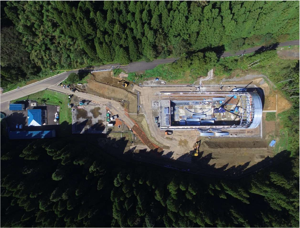
被覆施設 鉄骨建て方及び屋根施工中
