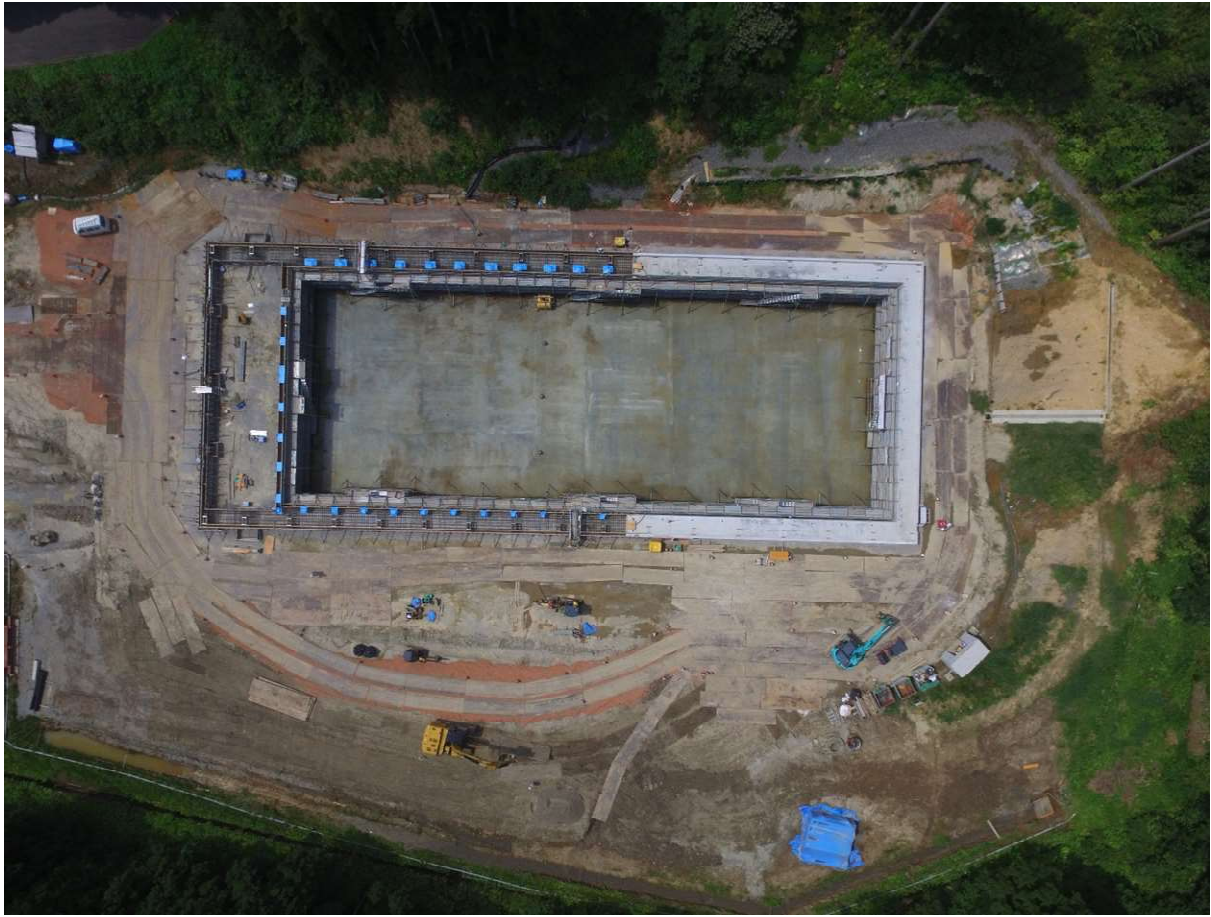
貯留構造物 コンクリート打設中
