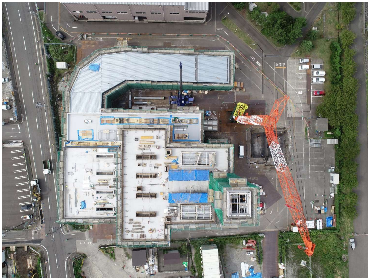
煙突内筒の据付中 他
