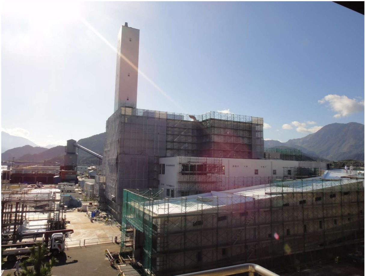
外壁の塗装中 他
