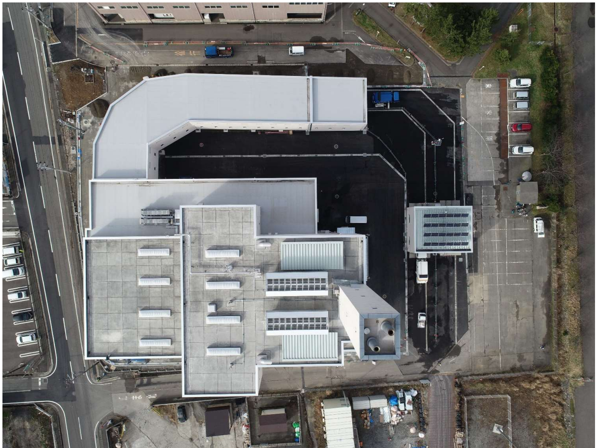
外構工事中、ごみ搬入中
