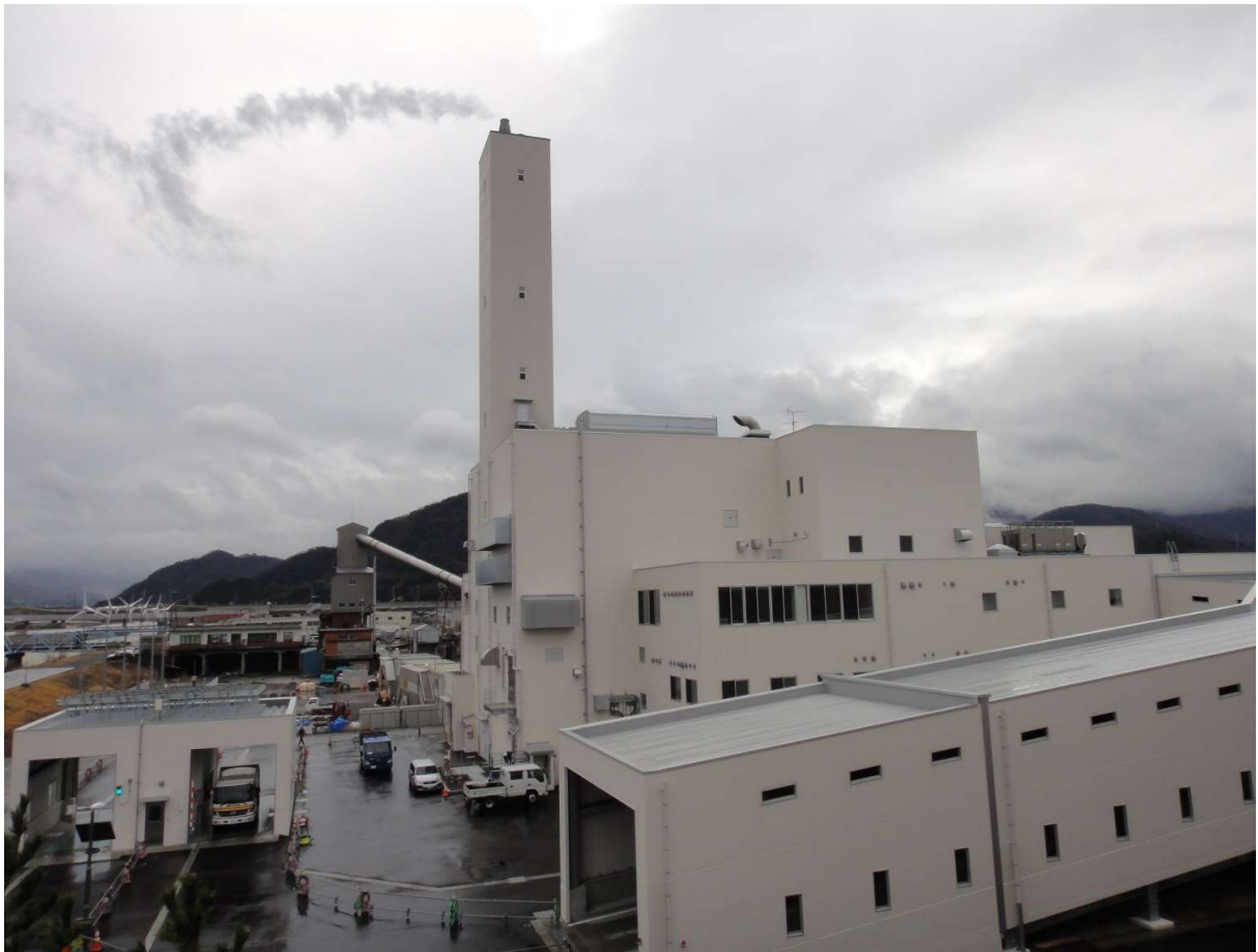
外構工事中、ごみ焼却開始
