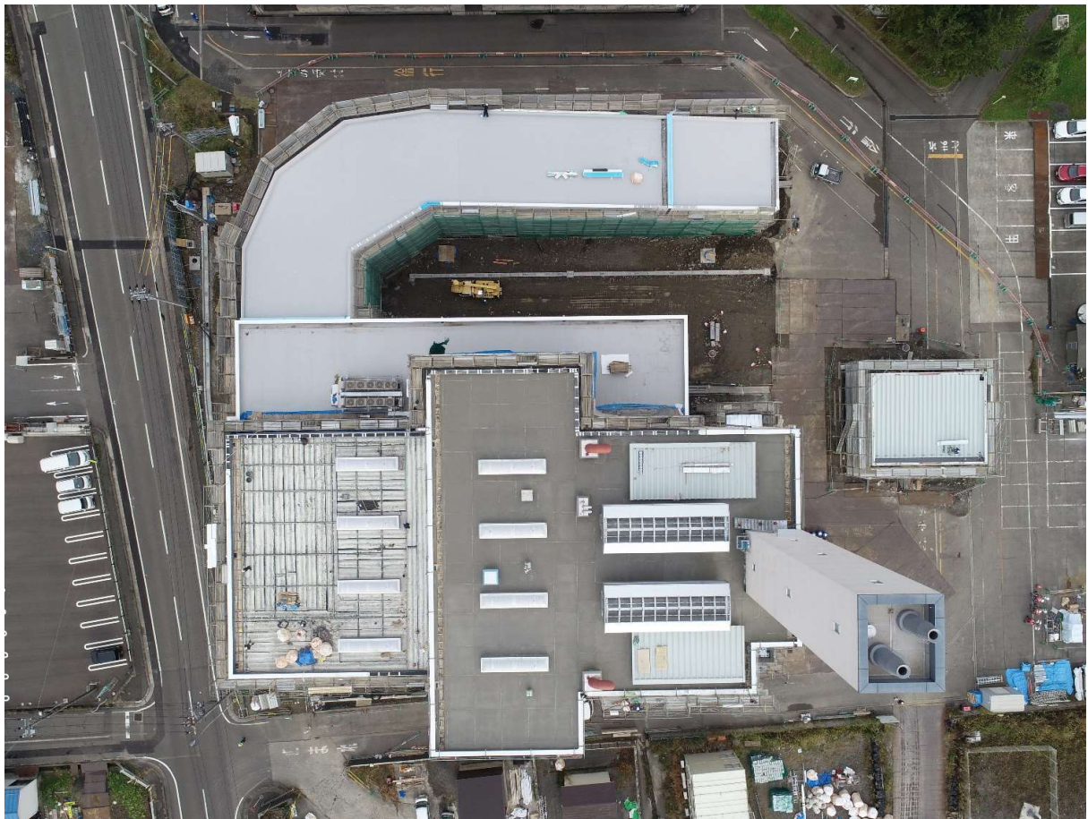
プラットホーム屋根の防水シート施工中
