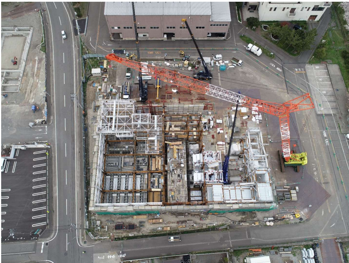
居室部分の鉄骨建て方中 他
