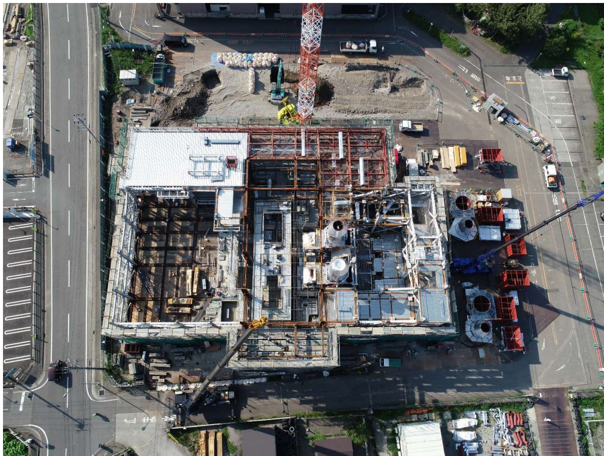
ランプウェイ部分の地盤改良中 他
