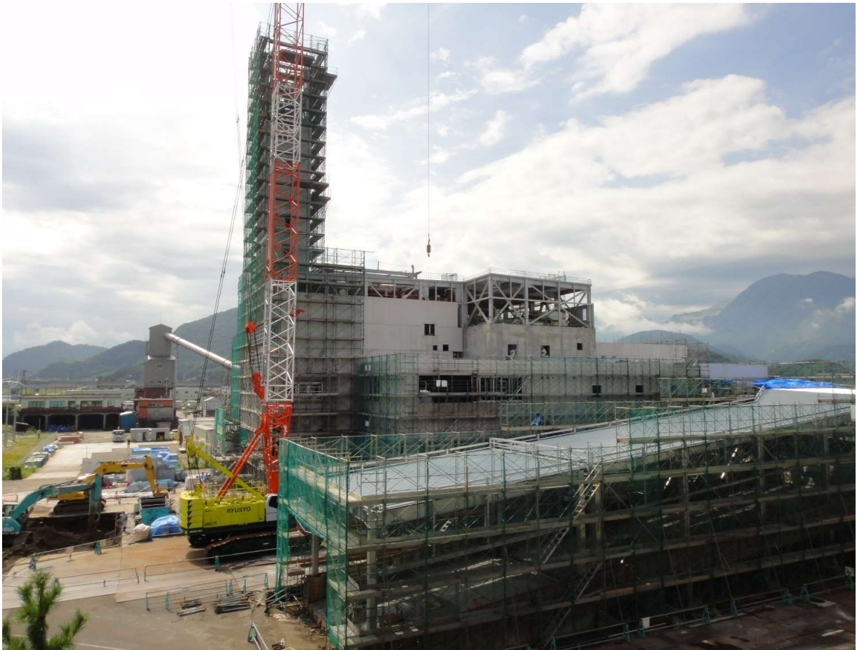
計量棟部分の地盤改良中 他
