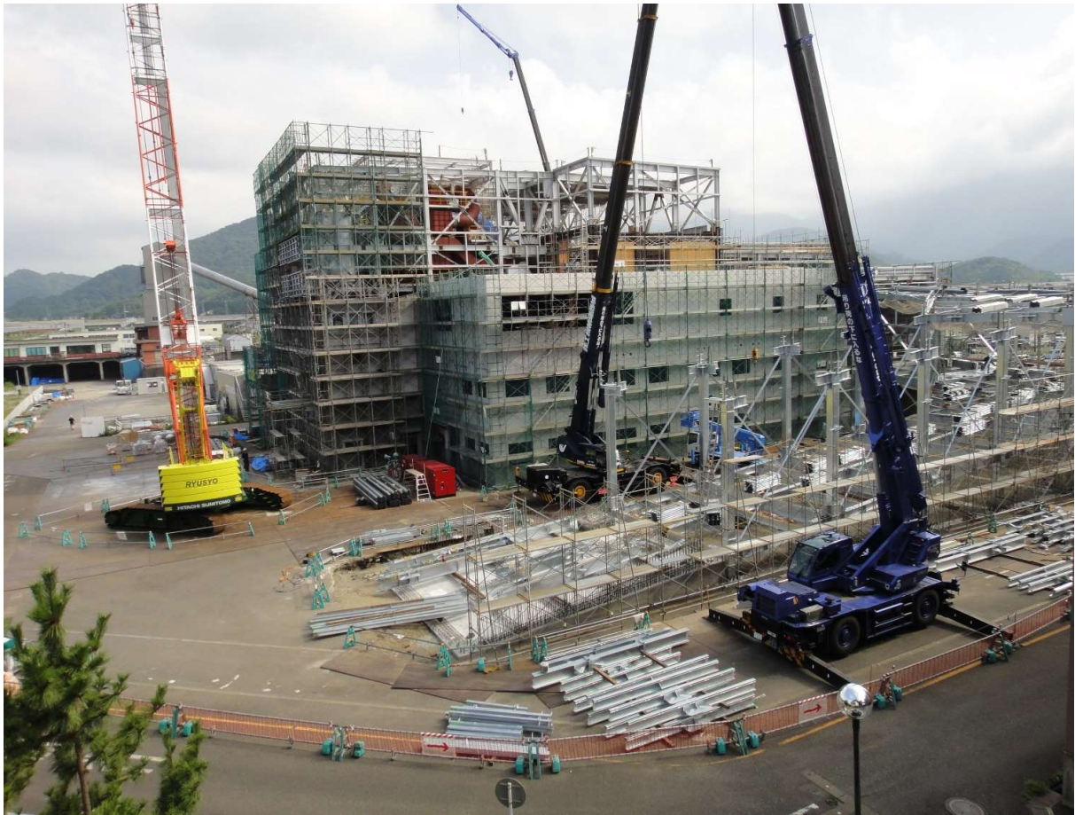
ランプウェイの鉄骨建て方中 他
