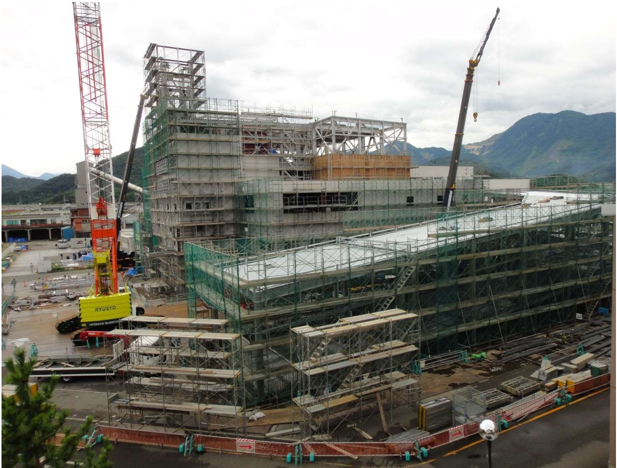
煙突廻りの鉄骨建て方中 他
