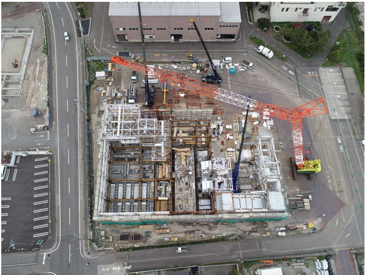
居室部分の鉄骨建て方中 他
