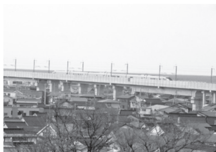
試験走行中の北陸新幹線（横町地内）
