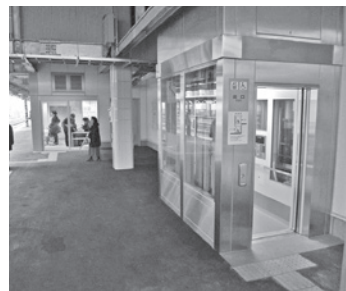
JR糸魚川駅のホーム上に設置されたエレベーター
