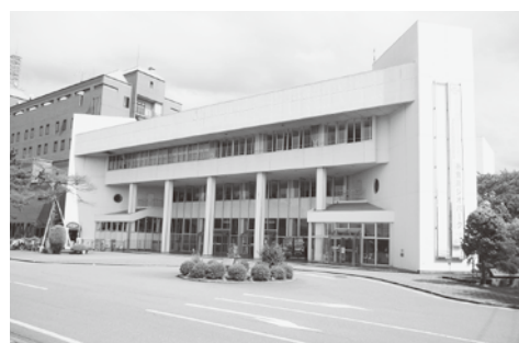
改修前の市民会館
