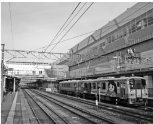
新幹線駅や自由通路の工事が進む糸魚川駅
