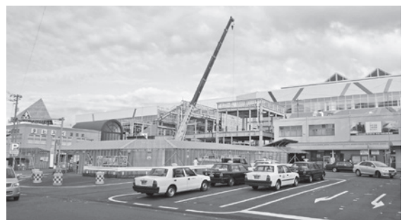
工事が進むJR糸魚川駅の新駅舎及び糸魚川駅自由通路
