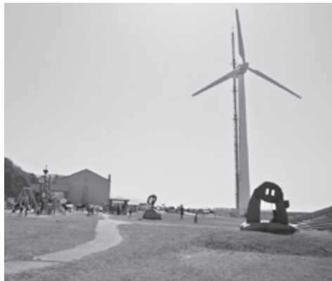
能生海洋公園内の風力発電施設
