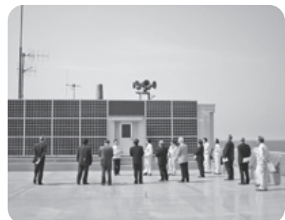
能生涯学習センター屋上の太陽光発電設備
