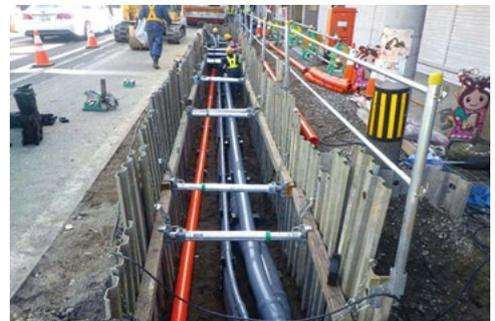
電線共同溝の埋設状況
