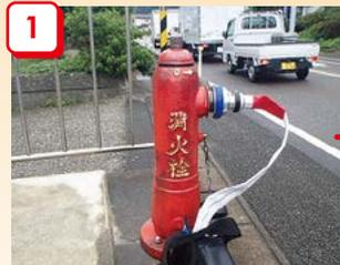
1 消火栓のキャップを外し、ホースバック(資器材)の65mm金具を接続する。
