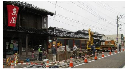
①、③ 無電柱化工事の状況と建設中のまちなみ駐車場雁木(R2.1.27)
