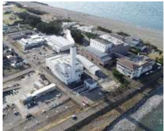
写真 清掃センター
