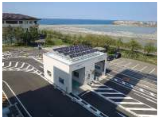
写真 太陽光発電施設
