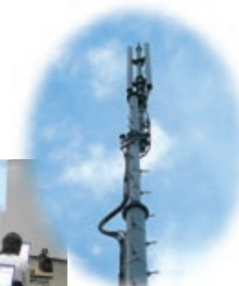
携帯電話中継塔
