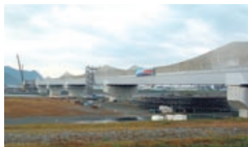
姫川橋りょう工事
