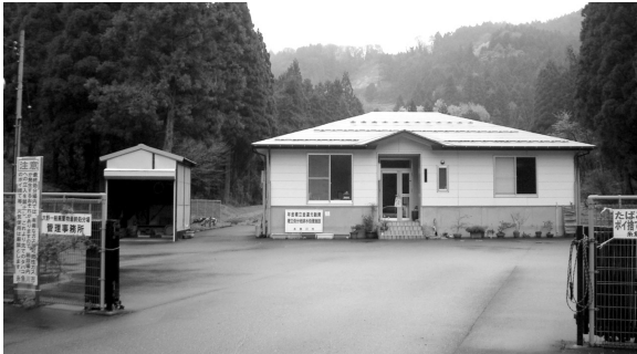
▲応急的な対策が施された大野埋立地
