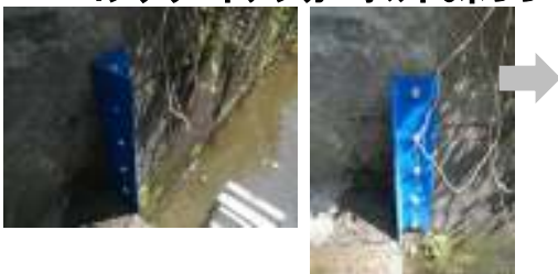
Step 1：堰アングルの設置 コンクリートアンカーボルト5本づつ
