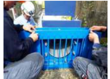
水車入口部のスクリーン設置
