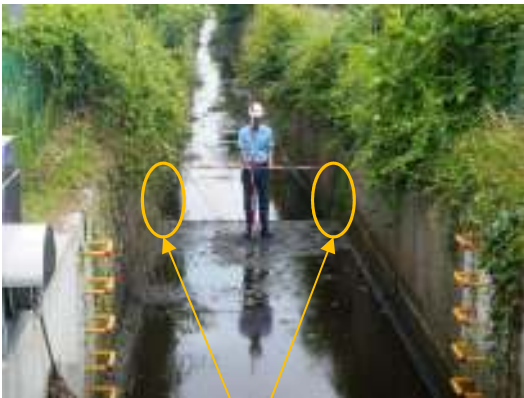
Step 1：堰アングルの設置 コンクリートアンカーボルト5本づつ
