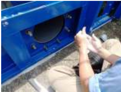
堰の水路の封水(間詰め)
