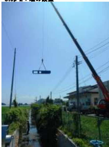
Step 2：堰の設置
