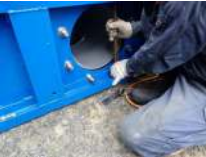
水車と堰をボルト止め
