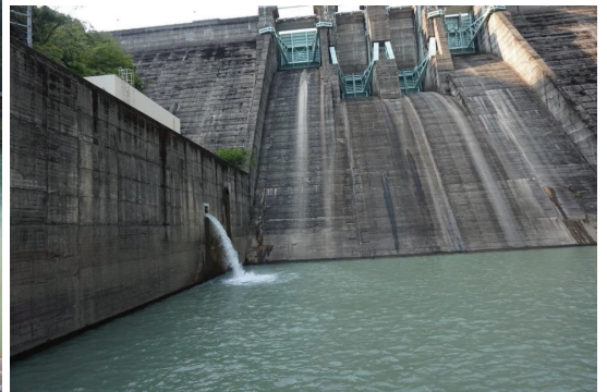
有田川町営二川小水力発電所
