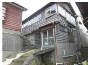
小泊地区の空き家 出典：いえかつ糸魚川 ホームページ
