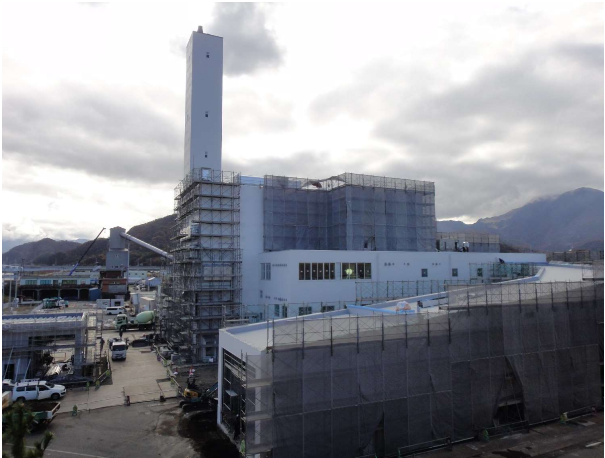
管理居室の内装工事中、炉室の電気計装工事中
