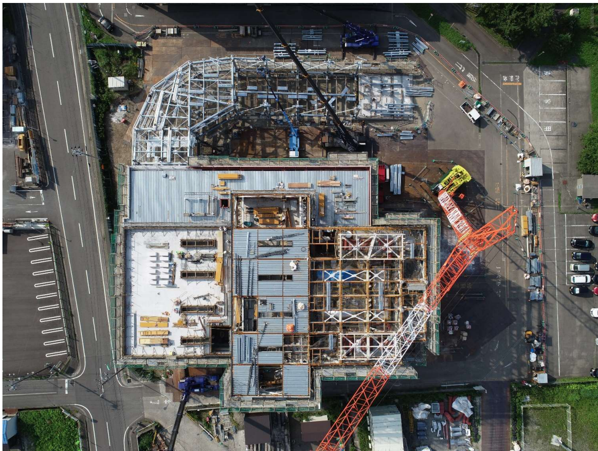
ランプウェイの鉄骨建て方中 他
