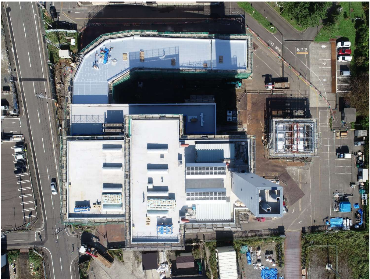
ランプウェイ屋根の防水シート施工中 他
