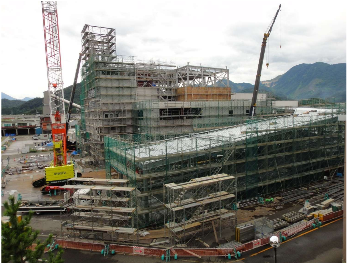
煙突廻りの鉄骨建て方中 他
