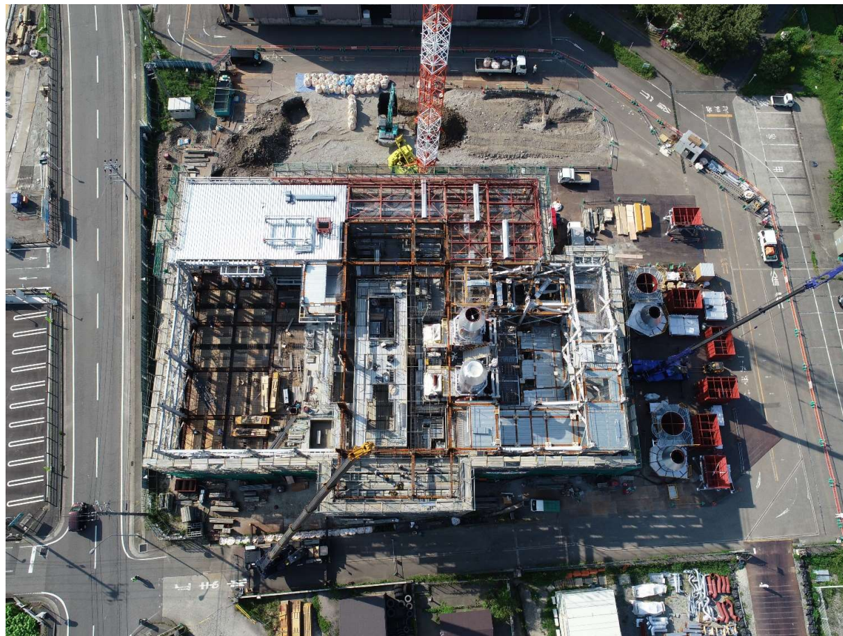
ランプウェイ部分の地盤改良中 他
